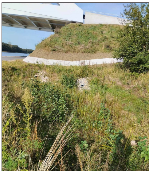
Hemelwaterbeheer aan de nieuwe bruggen over het Albertkanaal
