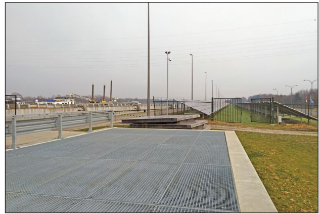
Sluis Hasselt met zonnepanelenpark
