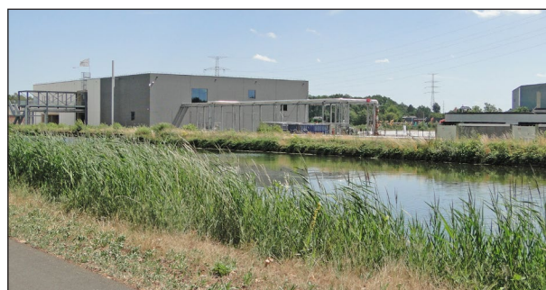
VITO Geothermie centrale
