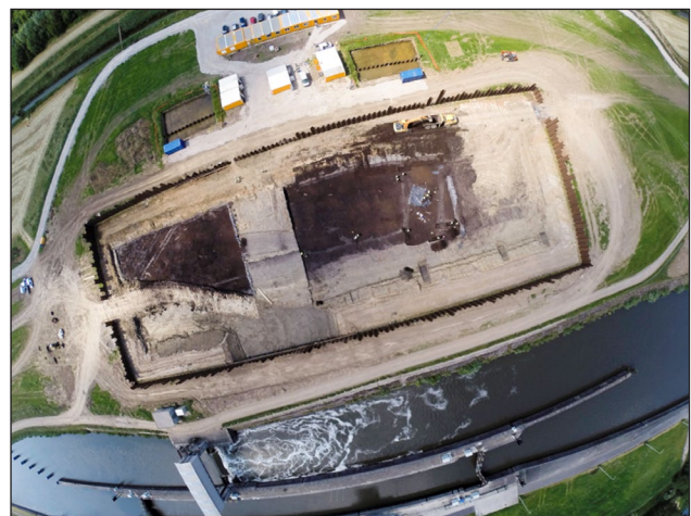
Werkzaamheden aan de stuw in Kerkhove (© UGent/GATE)
