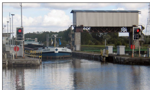
Sluis met stuwen in Oudenaarde
