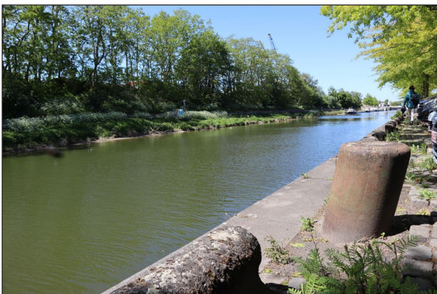
Natuurlijke versus gebetonneerde oever langs de Dender in Aalst
