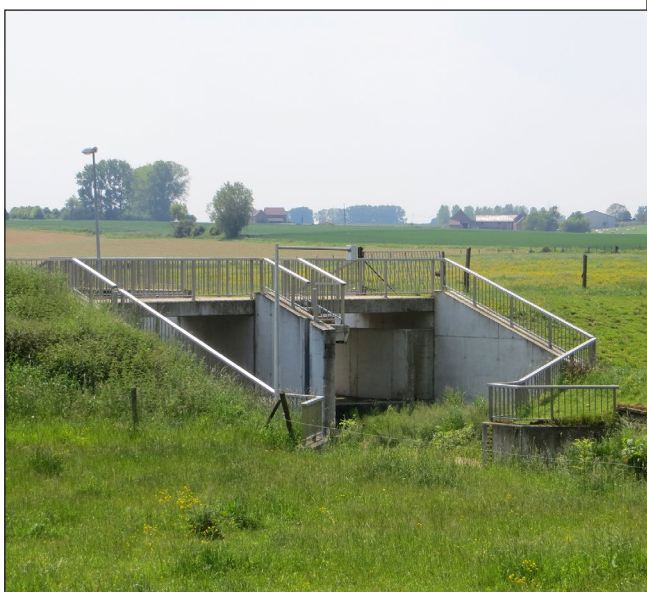
Constructie bufferbekken langs de Marke, zijrivier van de Dender
