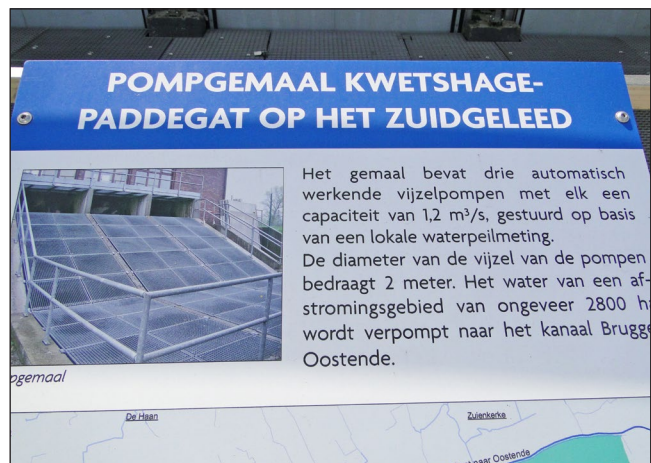
Infobord aan pompstation Kwetshage
