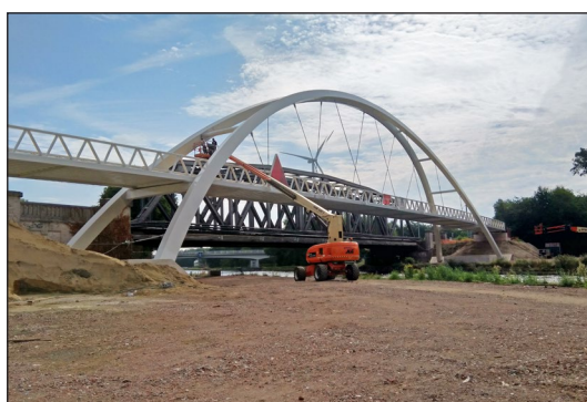
Aanleg nieuwe verhoogde fietsbrug in Herentals
