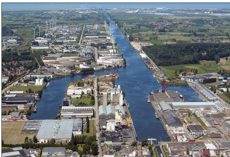
Zicht op het Boudewijnkanaal
