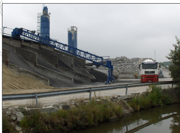
Betonbedrijf Holcim Aalst
