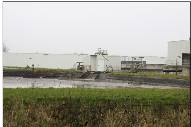
Groenten- en fruitverwerker Greenyard Prepared in Bree doet aan afvalwaterzuivering en heeft op haar site langs het kanaal een groot waterbekken.
