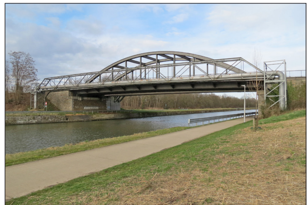
Leidingenbruggen over het kanaal voeren drinkbaar water naar Zutendaal, Lanaken, Kanne en omliggende gemeenten. Enkel de streek van Voeren krijgt haar drinkwater van de Maas.
