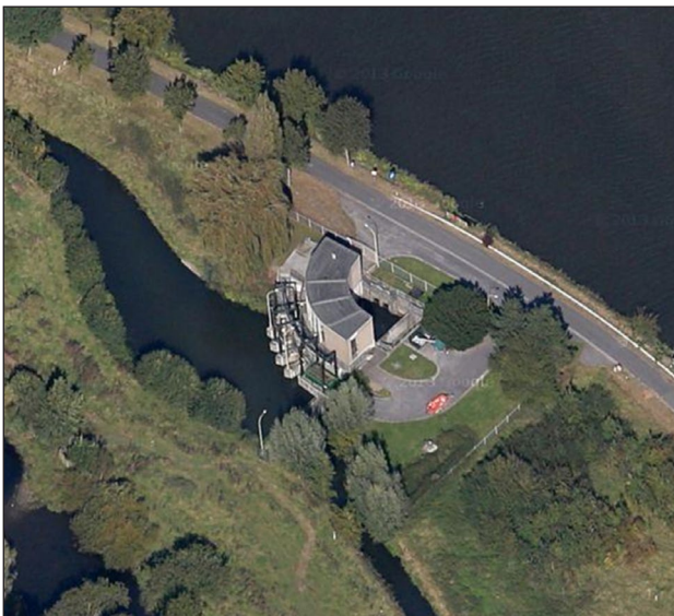
Het Duivelsputgemaal in Vinderhout (Lovendegem) regelt het water van de Oude Kale en de Meirebeek.
