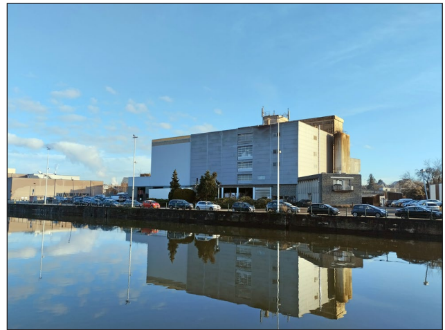
Molens De Dobbeleer in Halle verwijderde haar laad- en losinstallatie. Dit bedrijf maakt niet langer gebruik van het kanaal voor vrachtovervoer.
