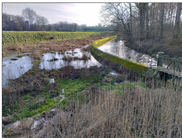
Overstort tussen Zenne en kanaal in Lembeek
