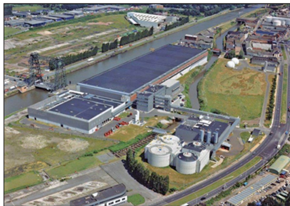
RWZI Brussel-Noord, gelegen tussen het Zeekanaal en de Zenne © Jan De Nul
