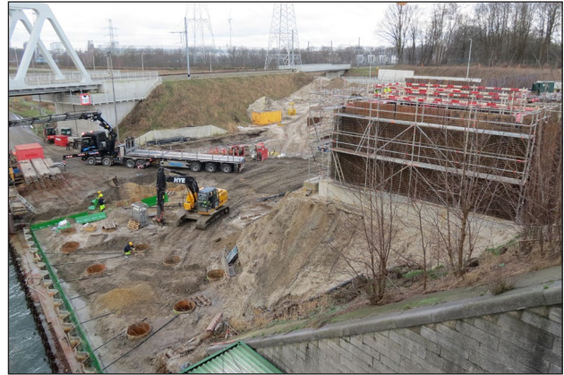
Op het Albertkanaal in Genk bouwt De Vlaamse Waterweg een pompinstallatie met waterkrachtcentrale aan het sluiscomplex.
