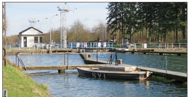
Sluis Neerharen - De Heirbaan die de historische verbinding van het dorp Neerharen en kasteel Pietersheim naar de abdij van Hocht vormde, werd doorsneden met de aanleg van het kanaal. De verbinding werd hersteld door de brug over de sluis.
