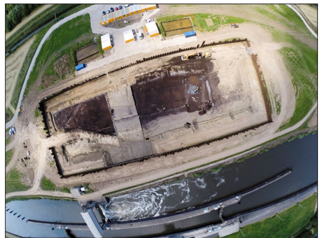
Werkzaamheden aan de sluis in Kerkhove (© UGent/GATE)
