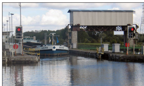
Sluis met stuwen in Oudenaarde
