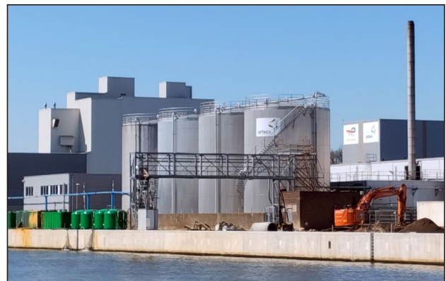
Artec Coolants produceert stoffen voor koeling van motoren, elektronica, data centra, batterijen voor energieopslag.
