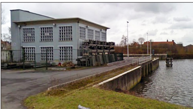
Pompgebouw in Bossuit (bron: GoogleMaps)
