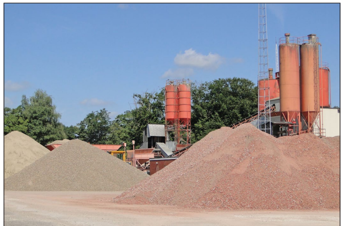
Betoncentrale Van Gorp
