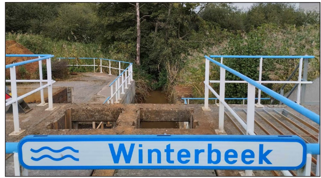
Beken worden via een duiker onder het kanaal door geleid
