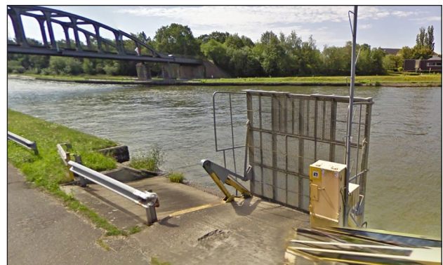
Slipway Schipperstraat, Beringen. Deze constructie laat toe plezierbootjes in het water te laten. © Google Maps
