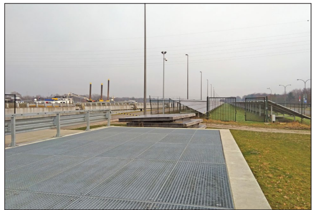
Sluis Hasselt met zonnepanelenpark
